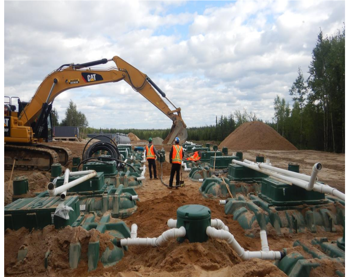
Installation du système de traitement des eaux usées Campement Fénelon, 2021
